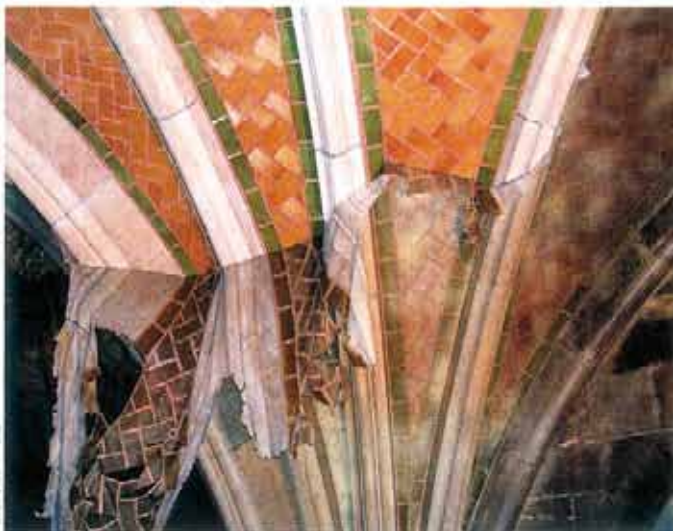
Ein mit »Arte Mundit« gereinigtes Gewölbe, von dem die polymerisierte Naturlatexschicht abgezogen wird
