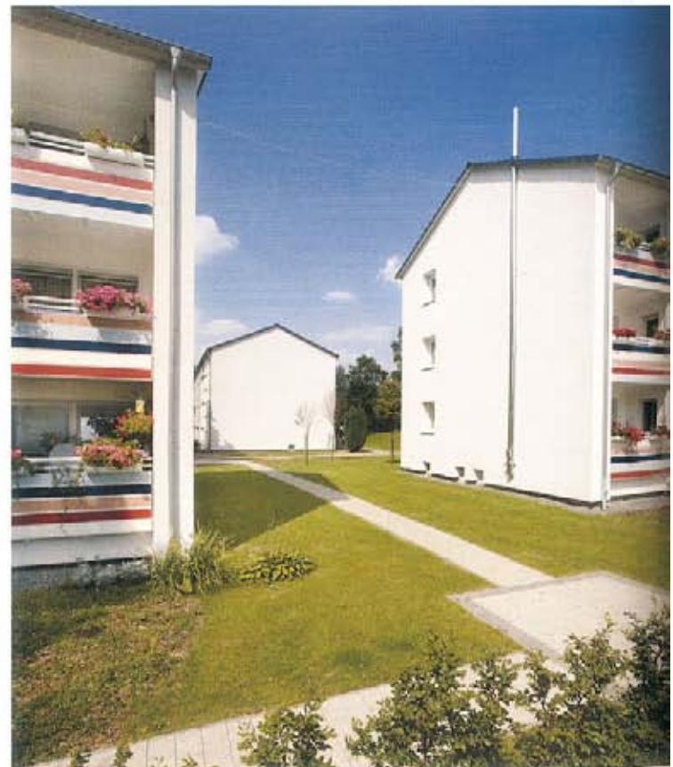
Alle Giebelwände wurden in demselben Grauton ausgeführt, was ihnen optisch mehr Gewicht gibt und die Gebäude verbindet.
