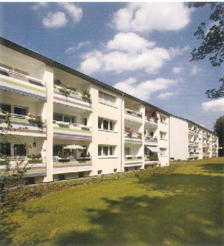
Einige Fassaden sind reinweiß beschichtet, was die dezente Farbigkeit anderer Elemente stärker wirken lässt. Die Farbabstufungen liegen im sandfarbenen Natursteinbereich.
