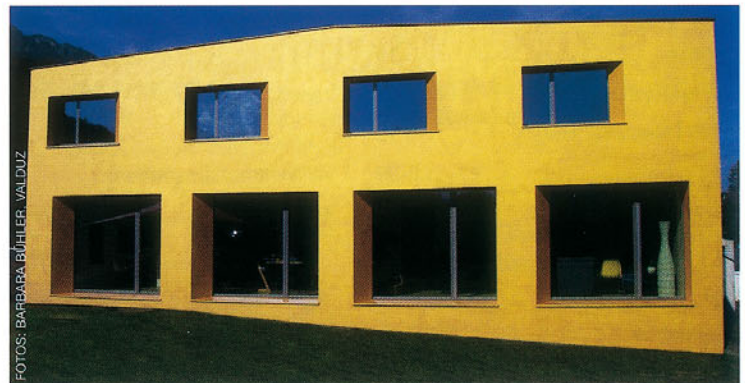
Nach dem Grundanstrich mit Keim Soldalit folgte der Lasuranstrich mit Keim Granital Lasur.
