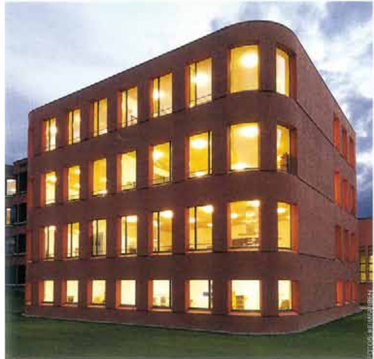
Mit der mineralisch matten Lasur Keim Concretal wurde die Sekundarschule Giacometti in Chur versehen.
