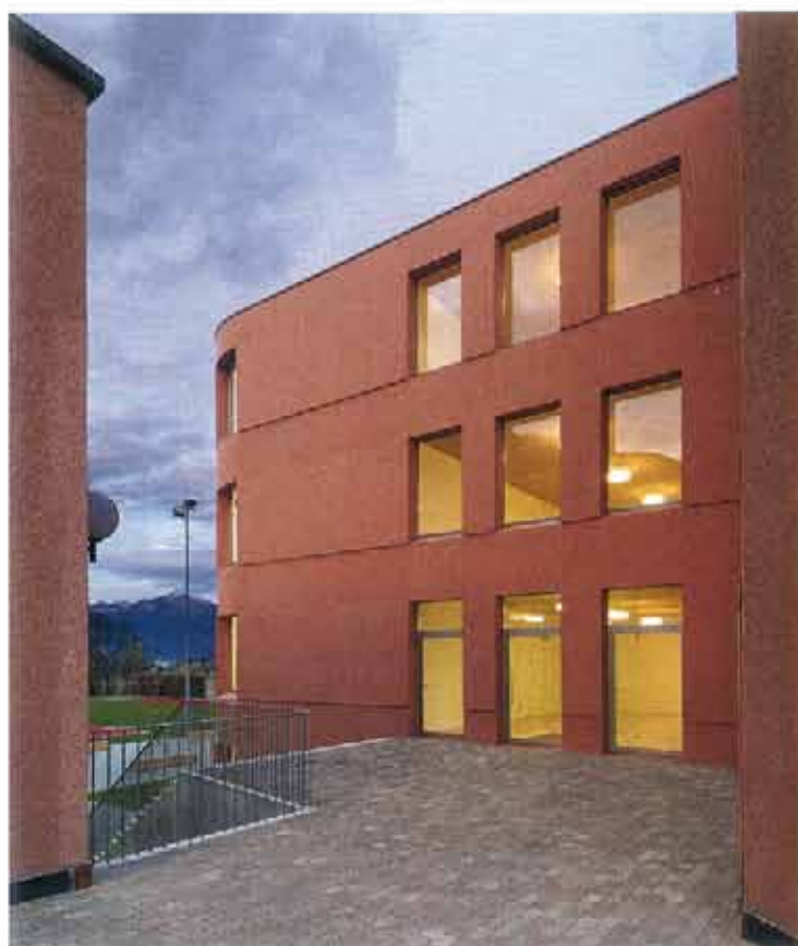
Besser als durchgefärbter Beton: Durch das exakte Nachmischen der Lasur wurden Farbabweichungen vermieden.
