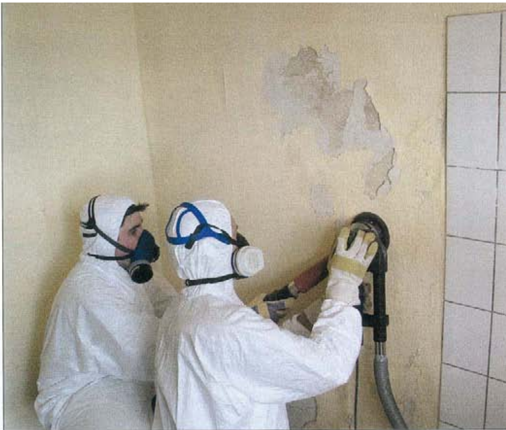
Abfräsen befallener Flächen. (Fotos: Keimfarben)
