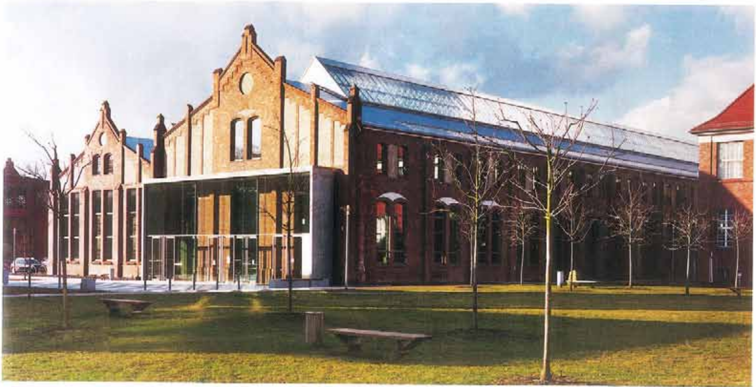
Das durchgehende Oberlicht ermöglicht eine natürliche Belichtung der inneren Neubauten. Der vorgestellte Betonbügel deutet auf eine neue Nutzung
