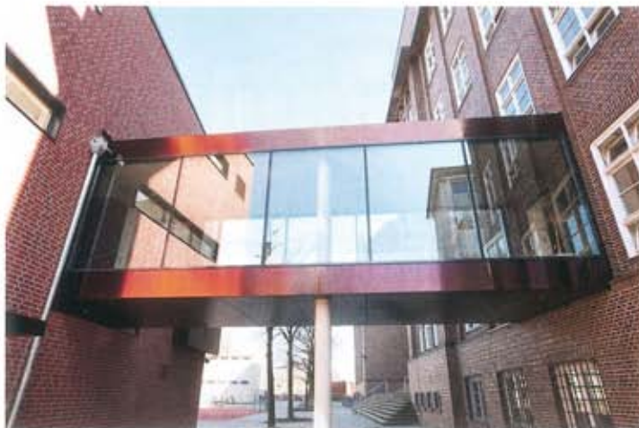
Die Glasbrücke zwischen alt und neu wurde ebenfalls mit rotem Edelstahlblech verkleidet.
