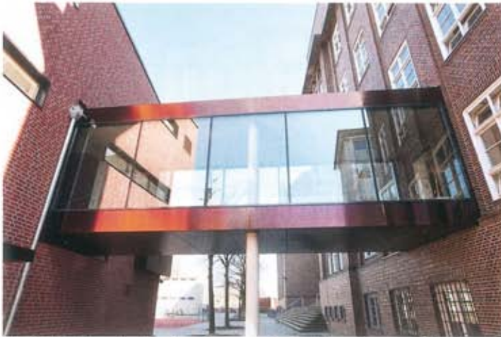
Die Glasbrücke zwischen alt und neu wurde ebenfalls mit rotem Edelstahlblech verkleidet.
