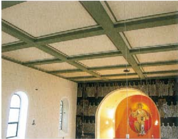
5 Die neue, um 15 cm abgehängte Decke besteht aus individuell angefertigten Gipsplattenkästen samt Dämmung und Dampfsperre, die auf speziell hergestellten U-Profilen befestigt wurden. So wird dem Brand- und Wärmeschutz Rechnung getragen.
