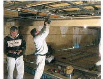
7 Montage der neuen Unterdecke aus vorgefertigten Profilen und Gipsplatten.
