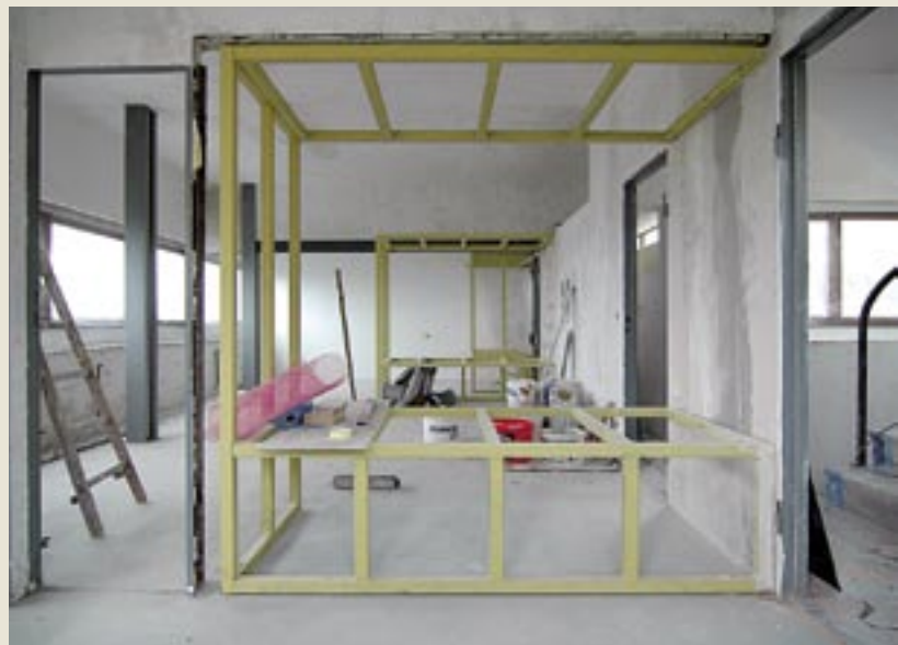
Das Flugdach nach erfolgreicher Rekonstruktion. Rechts der Nachbau der für die Raumauthentizität wichtigen Bettschränke. Aus statischen Gründen kam eine Unterkonstruktion aus Quadratrohren zum Einsatz.
