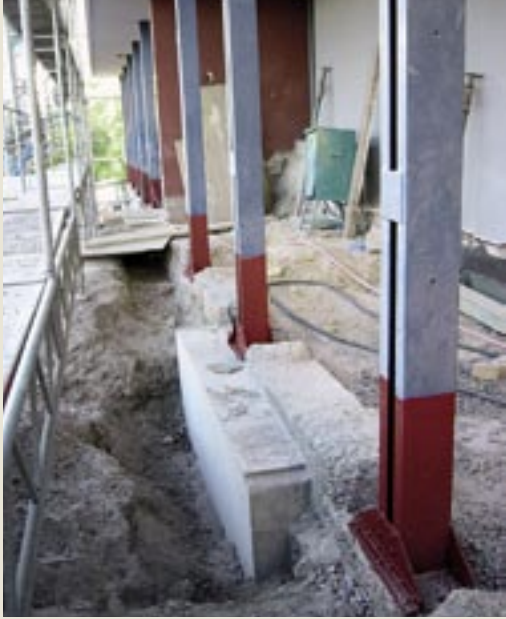
Durch die Freilegung der alten Mauerkrone der östlichen Stützwand wurden auch die Stahlstützen von ihrer Ummauerung befreit.
