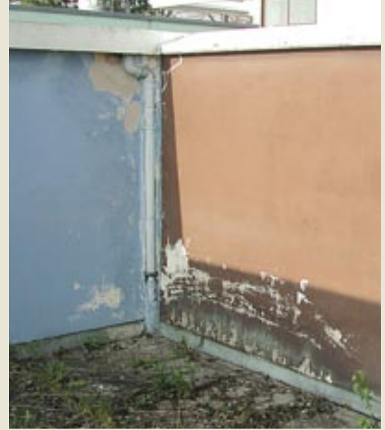
Ausblühungen, Abplatzungen und Feuchteschäden kennzeichnen die Trennwand auf der Dachterrasse im Jahr 2002.
