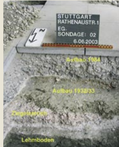
Mit archäologischen Verfahren klärte man den ursprünglichen Aufbau des Erdgeschosses und der Eingangsebene.
