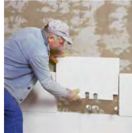
Aserrado con serrucho manual normal (diente fino)
