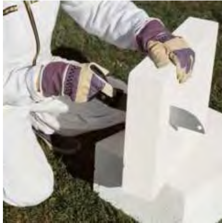
Aserrado con serrucho manual normal (diente fino)
