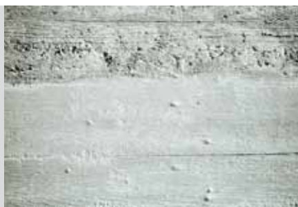
Lechada para cubrir coqueras, aplicada a cepillo. Se mantiene la textura hasta de las tablas de encofrado.
