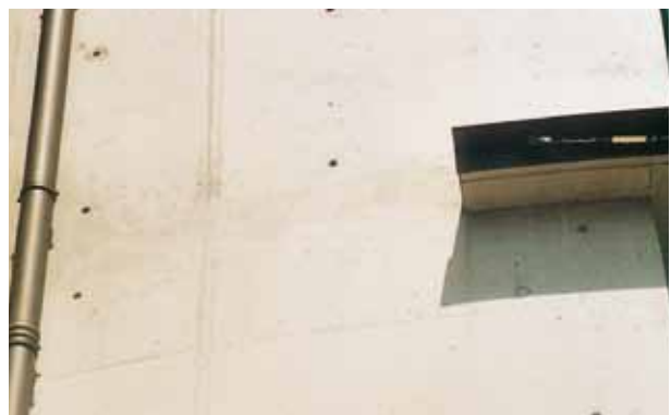
Reducción del impacto visual de los enmasillados, o igualación completa con aspecto mineral
