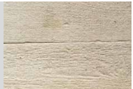
Tendido rascado, aplicado con llana de esponja o de goma dura. Se mantiene la textura del encofrado entablillado.
