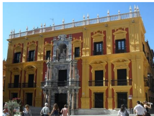
Después de la intervención
