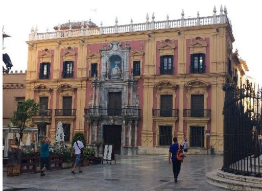
Fachada antes de la intervención
